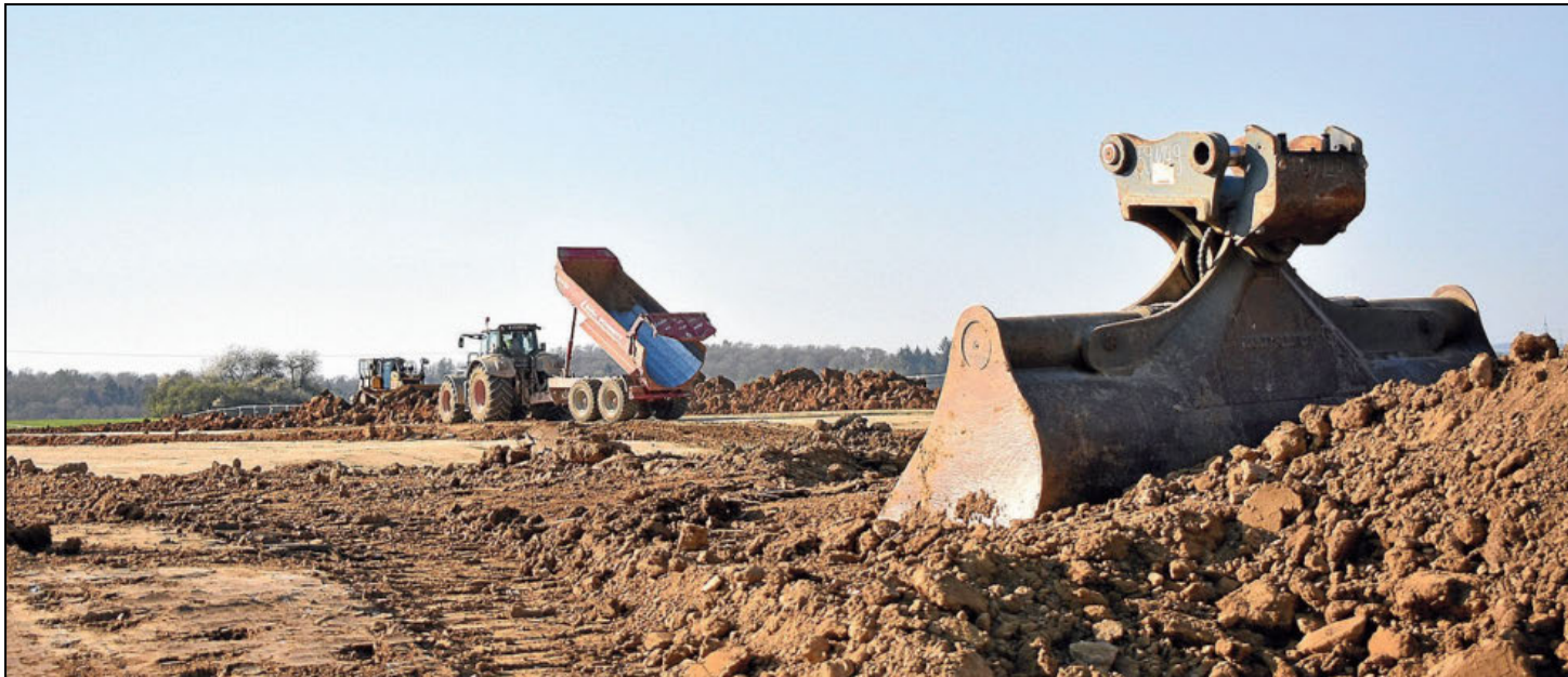
Auf eine neue (gleichmäßigere) Ebene hebt man derzeit das rund 63 000-Quadratmeter-Areal, auf dem die Schweizer Firma „Interroll“ für rund 40 Millionen Euro ein neues Werk baut. Foto: Heiko Schattauer
